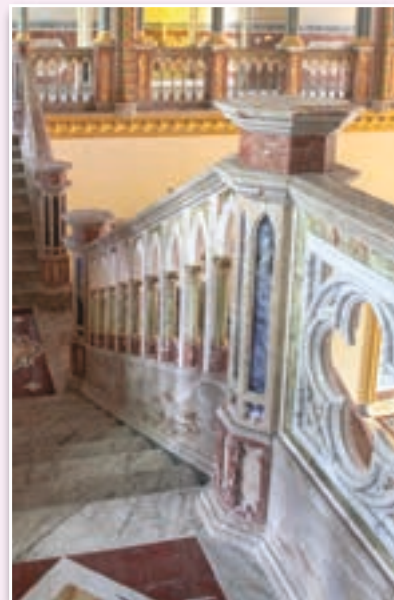
Escalera y pasamanos de piedra
